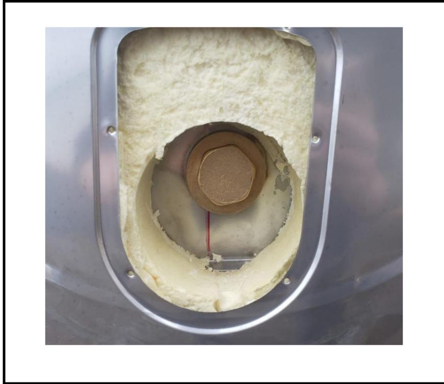
Após a instalação do acoplado verifique se o TAMPÃO está corretamente apertado e se há algum vazamento, caso ocorra vazamento remova a tampa e utilize um veda rosca e aperte o mesmo para cessar a vazão do líquido.
